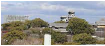
熊本城宇土櫓修復中
